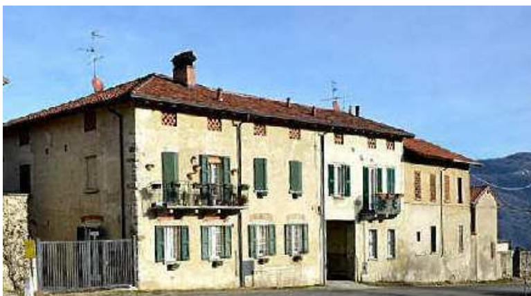
6. Ceregallo: il fronte strada ottocentesco
