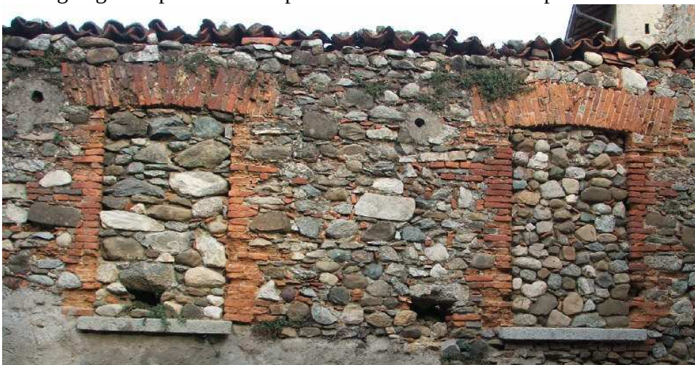
13. Ceregallo: materiali da costruzione delle case coloniche
